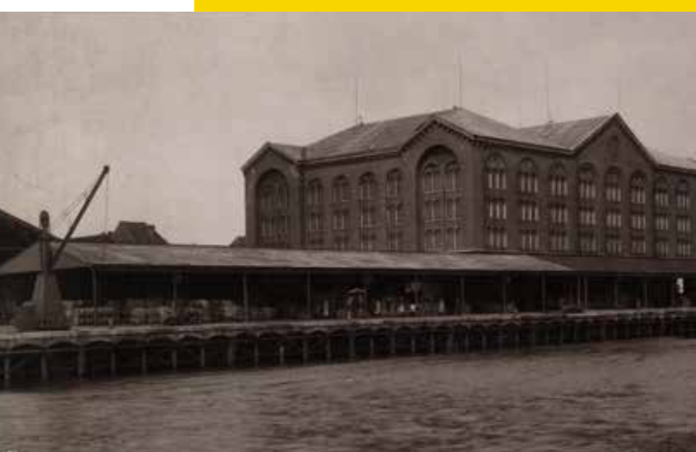
▼ Vue de l'Entrepôt le long du Handelsdok, détruit par les flammes en 1919. Photo Edmond Sacré. Collection Archives de la Ville de Gand
